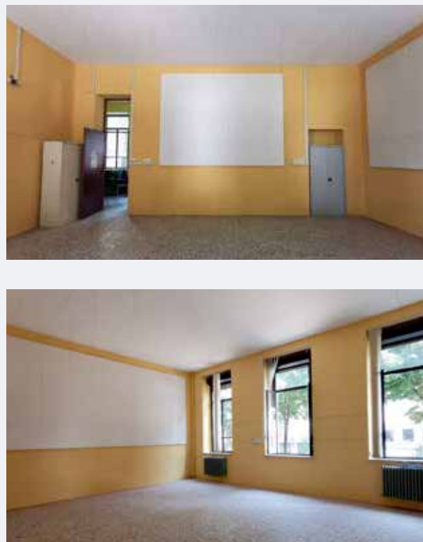
Figura 3.32 - Aula trattata, post-operam.
